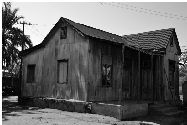
Ilustração 01 – Casa de madeira-e-zinco: construção para habitação típica dos bairros suburbanos da antiga Lourenço Marques, os principais centros difusores da marrabenta. Bairro da Mafalala, Cidade de Maputo (2016). Foto de Marílio Wane.
