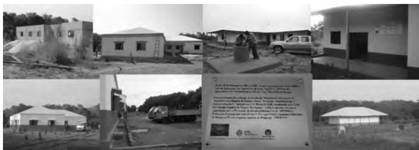
Ilustração 03 - Construção da unidade agroindustrial (esquerda). Casas do mel, interpostos de apoio aos agrupamentos de apicultores de cada setor (direita)
