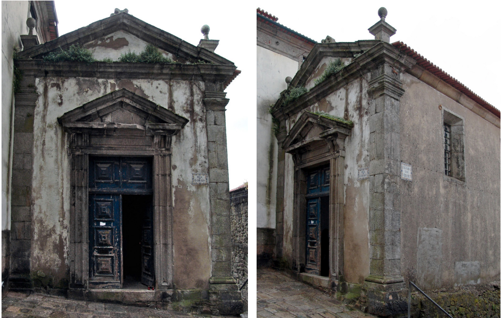
Fig. 1. Fachada e alçado da capela antes das obras
