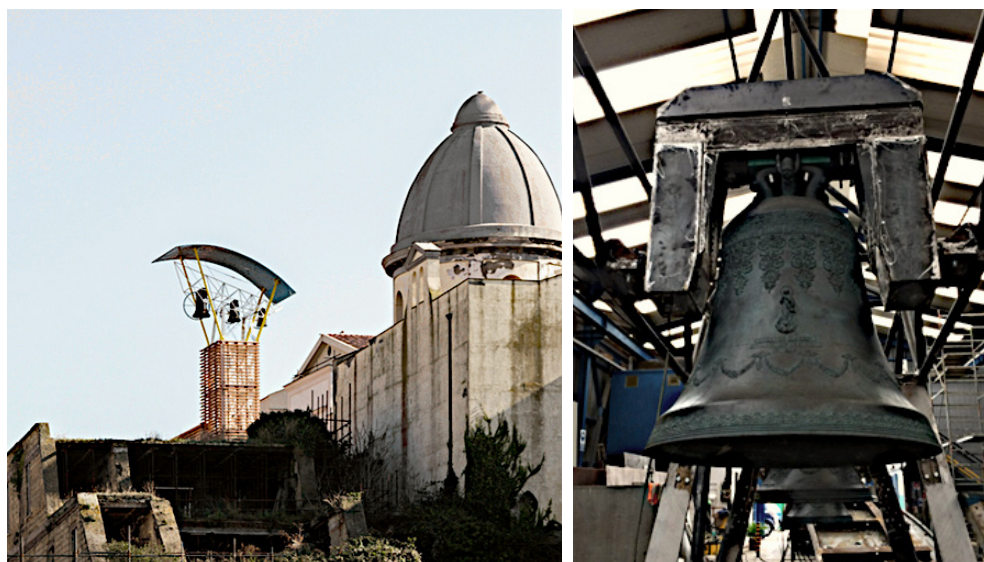
Fig. 8. Câmara sineira aberta, na parte superior, para possibilitar uma eficaz propagação sonora dos sinos preexistentes (à direita)
