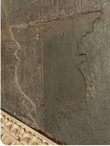
Fig. 2. Pormenor da rebarba da pintura na zona de interceção com a desaparecida mísula. Fonte: Fotografia do autor
