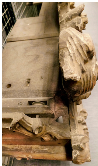
Figs. 3 e 3a. Sanefa da igreja do Convento das Carmelitas de Aveiro, c. 1779. Mecanismo torneado em madeira, interno e em roldana para suspensão dos cortinados
