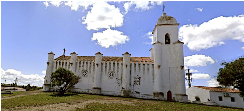
Fig. 7. Igreja da Mina de São Domingos, abril de 2024
