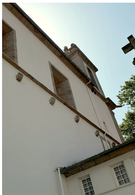
Fig. 4. Fachada ocidental da igreja paroquial da Foz, 2022
