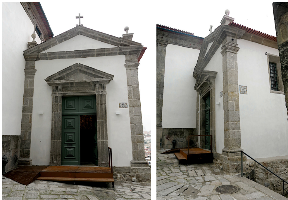
Fig. 12. Fachada e alçado da capela após as obras
