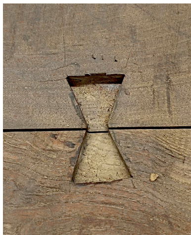
Fig. 4. Encaixe de uma dupla cauda de andorinha com vestígios de adesivo proteico no interior
