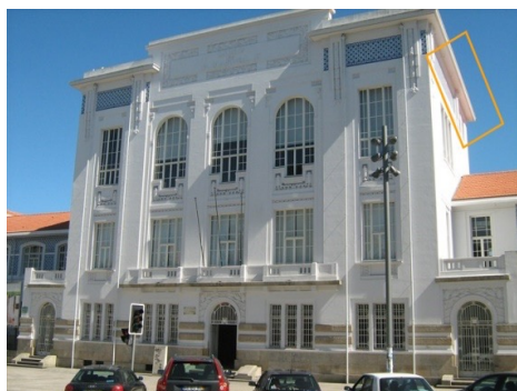
Figura 2 – Fachada da EBSRF com o espaço da mapoteca assinalado do lado direito do edifício.
