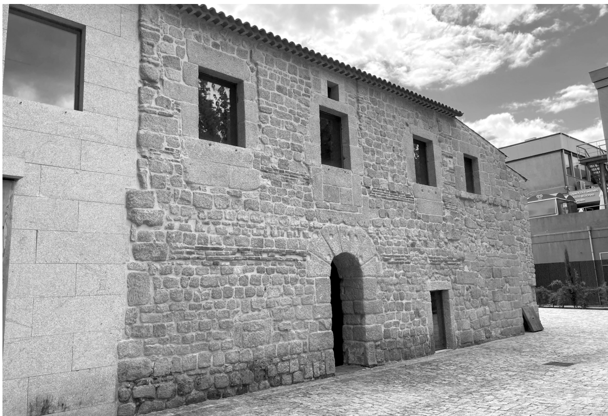
Fig. 8: Fachada do edifício da Fase II, após conclusão dos trabalhos de restauro e conservação.
