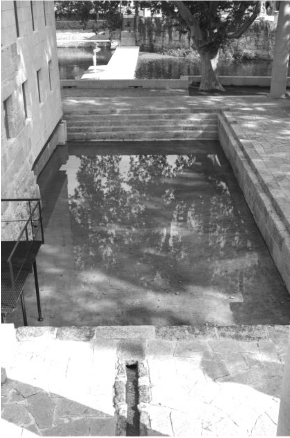
Fig. 12: Restauro da piscina exterior.
