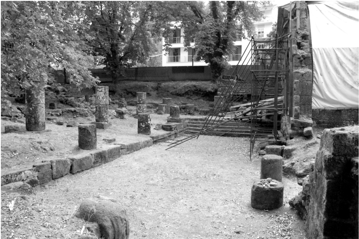
Fig. 4: Piscina exterior, no início dos trabalhos arqueológicos.
