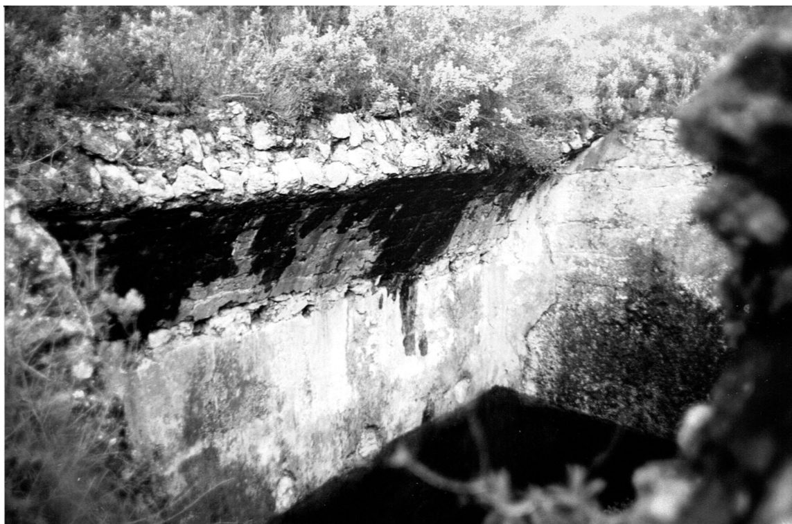
Fig. 6 – Vista parcial da cisterna fotografada em 1996 (Foto ICFF). Observe-se o revestimento de coloração avermelhada, destinado a assegurar a boa qualidade da água, combatendo a eutrofização e a estagnidade da cisterna.
