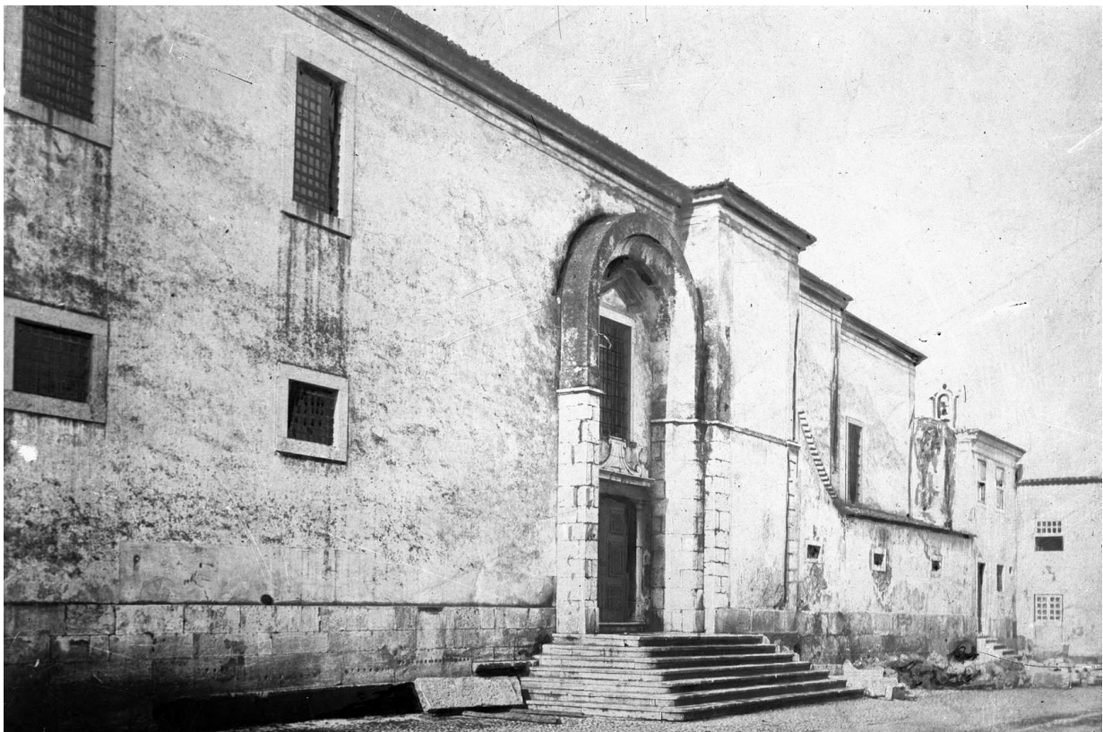
Fig. 4 – Portal lateral do Convento de Santana, em finais do século XIX (fotografia de J. A. Leitão Bácia, Arquivo Municipal de Lisboa | Fotográfico, Documento PT/AMLSB/CMLSBAH/PCSP/004/BAR/000813, disponível em http://arquivomunicipal2.cm-lisboa.pt/xarqdigitalizacaocontent/PaginaDocumento.aspx?DocumentoID=254567&AplicacaoID=1&Pagina=1&Linha=1&Coluna=1 ).
