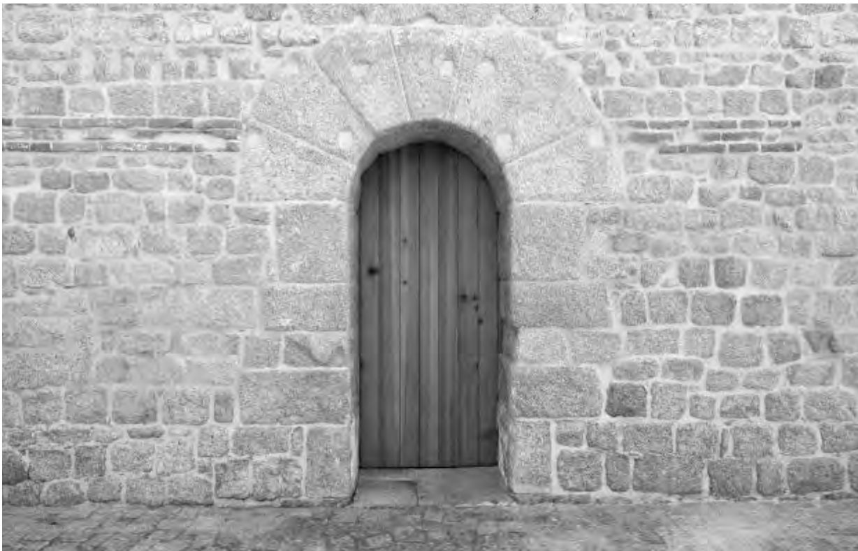
Fig. 9: Porta romana do edifício do edifício da Fase II, após conclusão dos trabalhos de restauro e conservação
