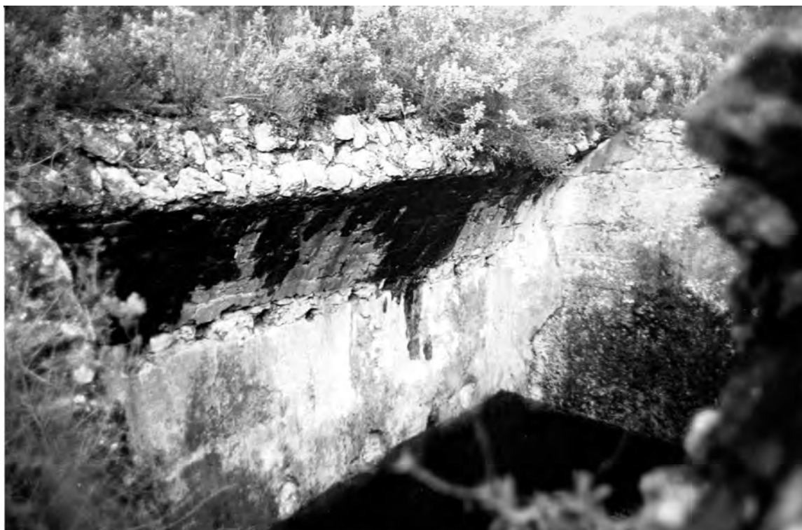
Fig. 6 – Vista parcial da cisterna fotografada em 1996 (Foto ICFF). Observe-se o revestimento de coloração avermelhada, destinado a assegurar a boa qualidade da água, combatendo a eutrofização e a estanquicidade da cisterna.
