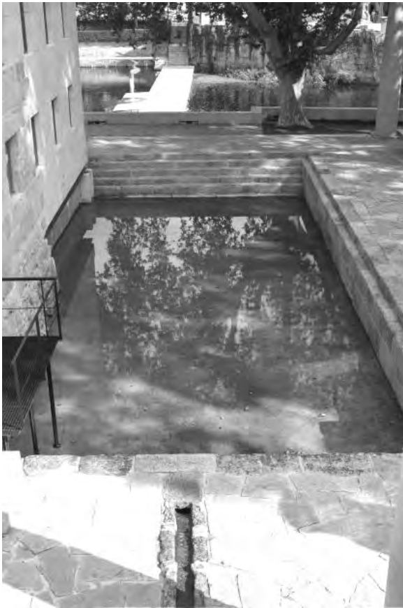
Fig. 12: Restauro da piscina exterior.
