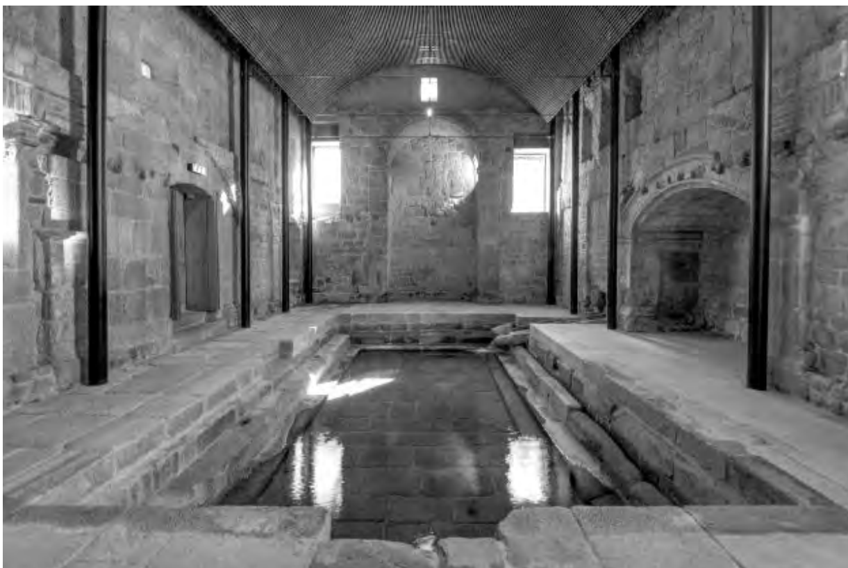
Fig. 10: Piscina interior do edifício da Fase II, após conclusão dos trabalhos de restauro e conservação.
