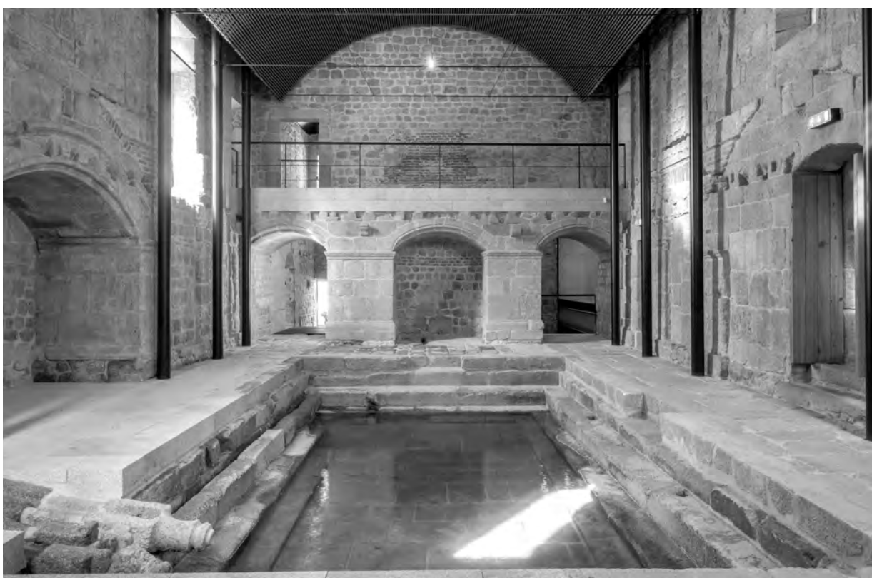
Fig. 11: Reconstrução da abóbada, vestígios do nicho absidiado norte e das êxedras laterais, após conclusão dos trabalhos de restauro e conservação.
