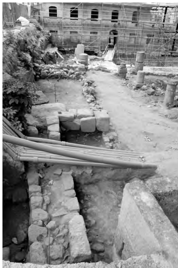
Fig. 14: Pormenores da escavação dos alicerces da igreja pré-românica (esq.)
