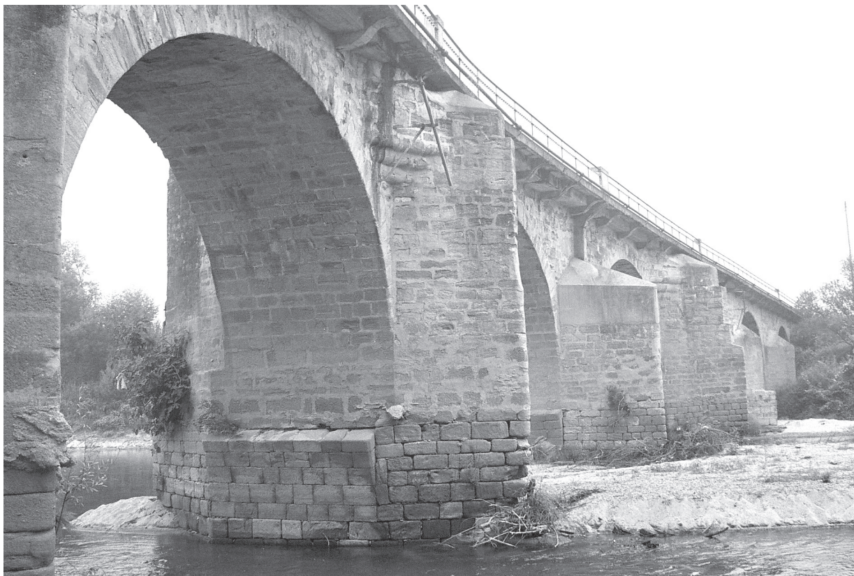
Fig. 4 – A ponte de Vouga, lado de montante, vendo-se em primeiro plano o pilar P6, seguido dos pilares P7 a P10 (fotografia do autor, 2001)
