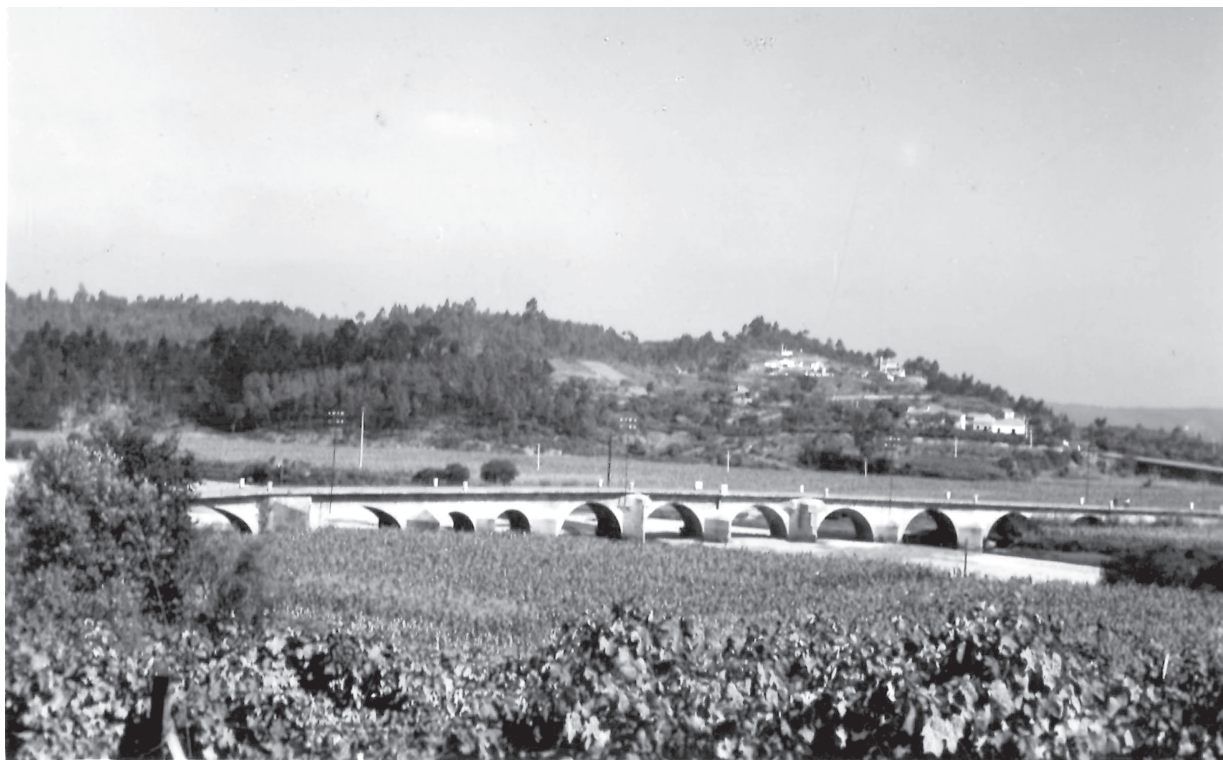
Fig. 2 – A ponte de Vouga, vista de montante e margem sul, em fotografia de António Nogueira Gonçalves datada de 1955/09/06 (conserva-se em álbum na Biblioteca Municipal de Arganil e foi reproduzida em GONÇALVES, 1959, Estampa XLIX)
