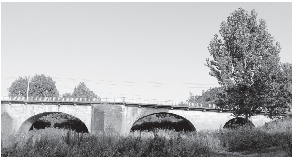
Fig. 5 – Os primeiros três arcos no extremo sul da ponte de Vouga, A3, A2 e A1, vistos de jusante, na actualidade
