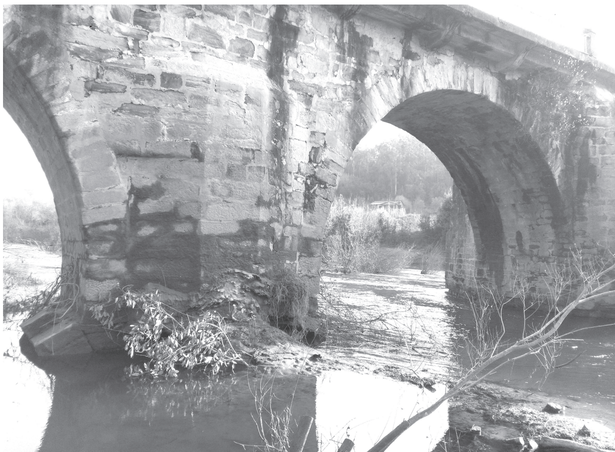
Fig. 8 – Pilar P9 e arco A9 vistos de jusante, sendo de notar o contraforte em P9
