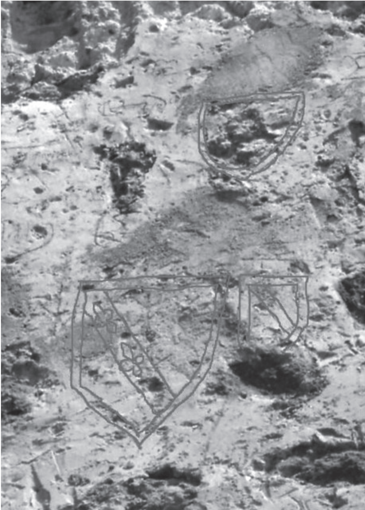
Fig. 6: Realce dos escudos heráldicos onde se pode notar a banda com flores-de-lis. No escudo mais pequeno apenas foi colocada a banda e o escudo acima está irremediavelmente danificado pela queda do reboco.
