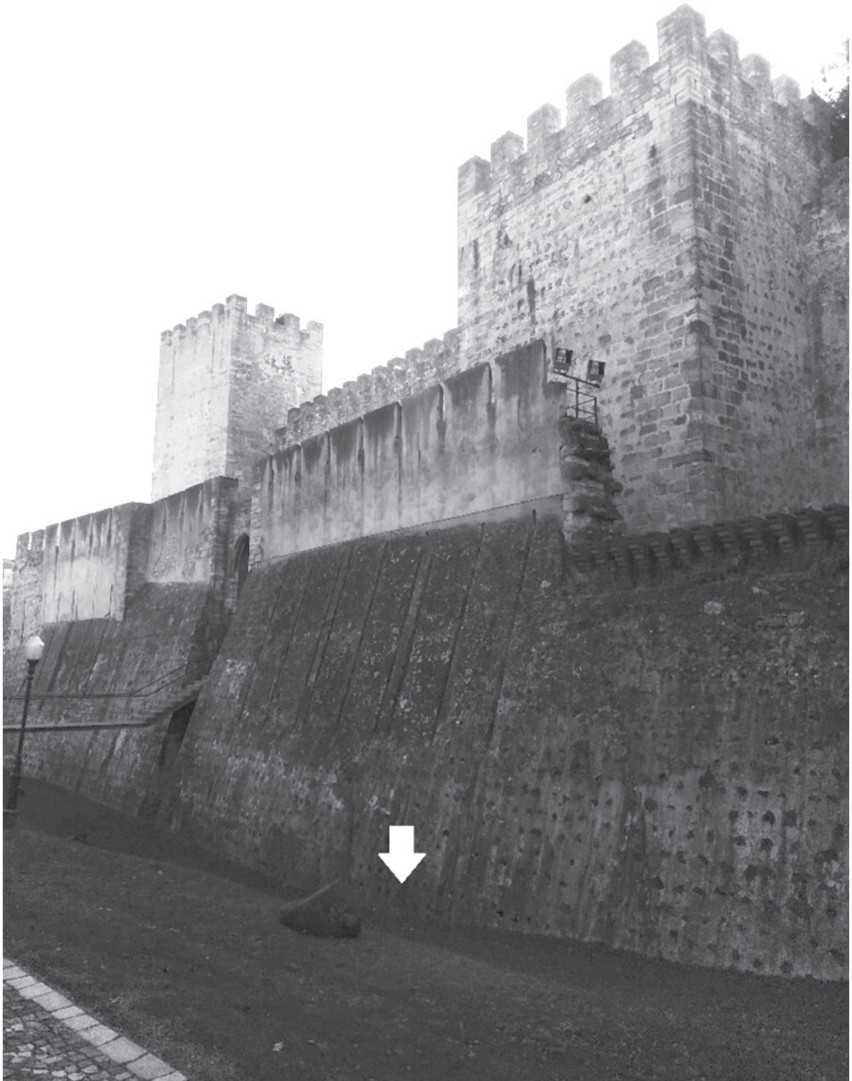
Fig. 14: Local onde se encontra a inscrição da foto anterior, na superfície da parede junto à linha do terreno do fosso.
