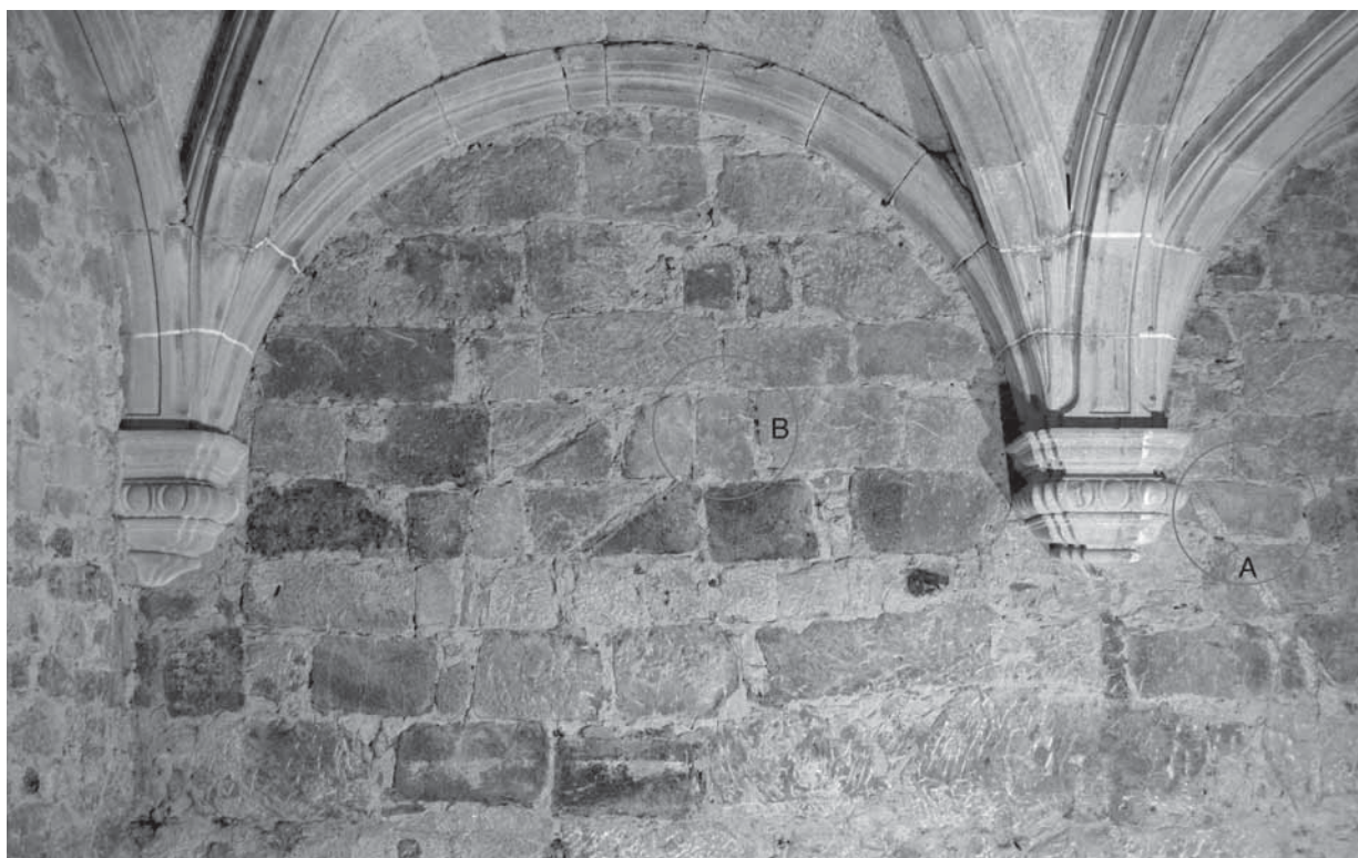
Fig. 5: Parede poente do refeitório depois de removida a camada de reboco. Localização da sigla em formato de chave (A), e de outra com formato cruciforme (B).
