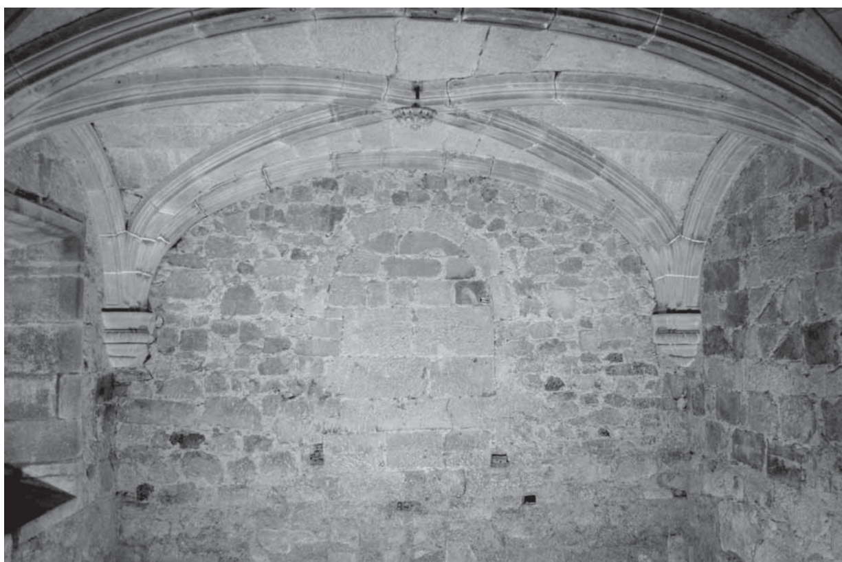
Fig. 6: Vista geral da parede sul do refeitório, depois de removida a camada de reboco. Nota-se um arco entaipado. Na parte média da parede, junto ao alicerce, situa-se a sigla circular ilustrada acima (Figura 4-2).
