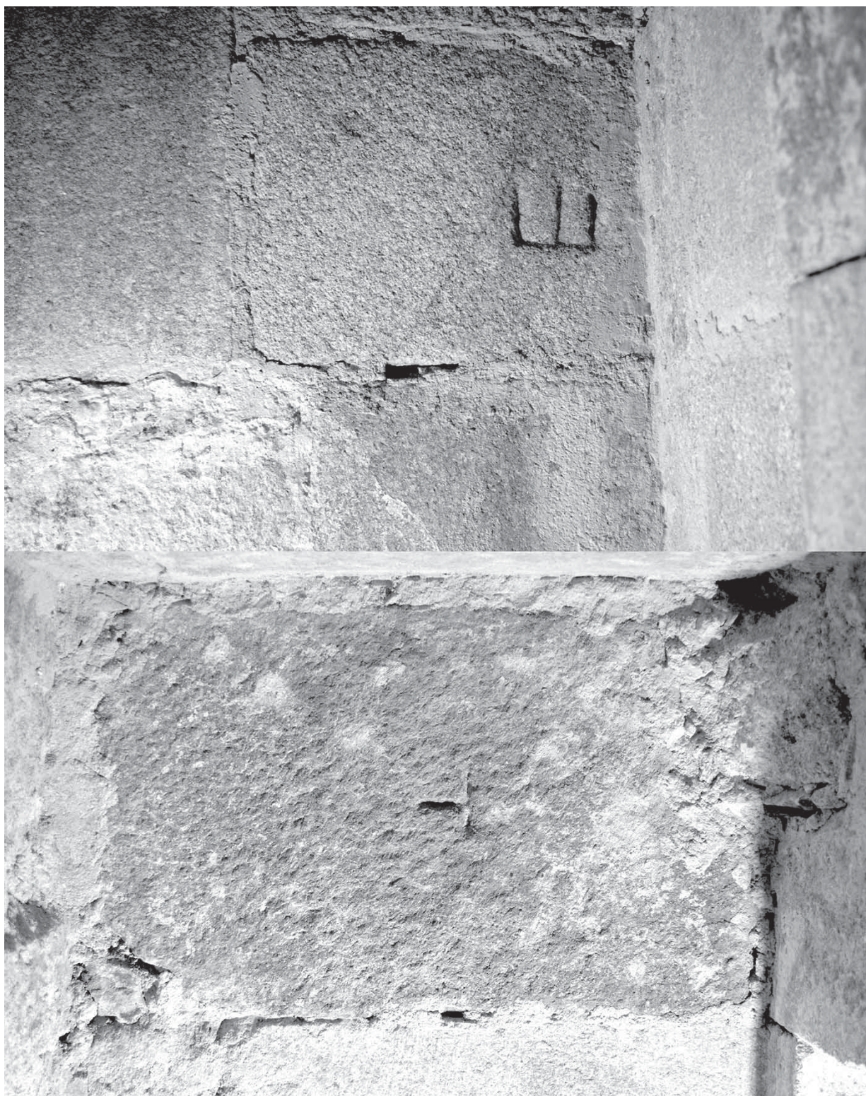
Fig. 3: Siglas em silhares situados no interior do “púlpito do leitor” do refeitório.
