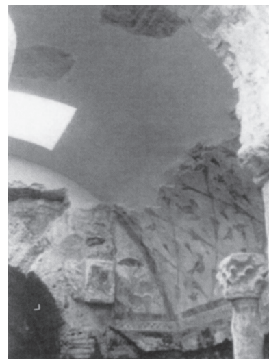
Fig. 4.2 – Aspecto de la bóveda reconstruida en la que se puede apreciar la ubicación aleatoria de los restos pictóricos con casetones, probablemente empleando la técnica del strappo . Foto Chamoso Lamas, tomada de (MONTENEGRO 2005: Foto 31), a su vez reproducida del Catálogo sobre Lugo no obxetivo de Manuel Chamoso Lamas. As nosas raíces .
