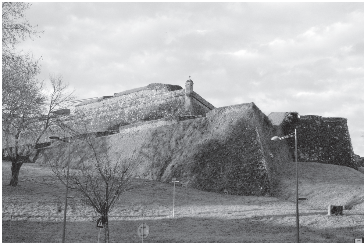
Fig. 7 – Potentes murallas da fortaleza de Valença.
