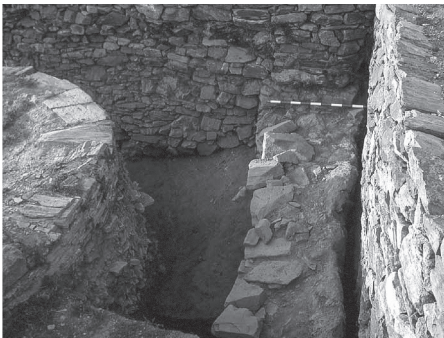
Fig. 9: San Chuis. Muro infrayacente a la muralla de módulos a la altura del sondeo 1 (Foto: VILLA y MENÉNDEZ 2011).
