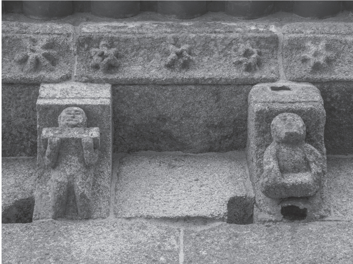
Fig. 17: Pormenor de dois modilhões da cornija norte. Pedreiros a carregar silhares. O pedreiro à esquerda na imagem poderá ser obra da DGEMN.
