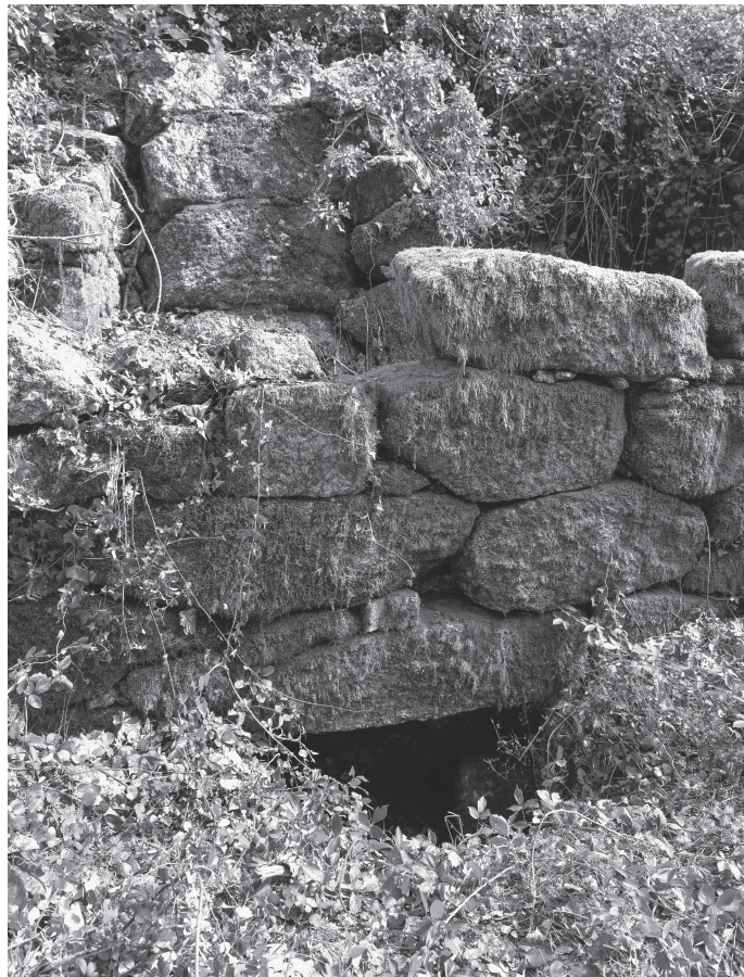
Fig. 6: Casa do moinho e engenho de linho de Vale Covo (Alvite)
