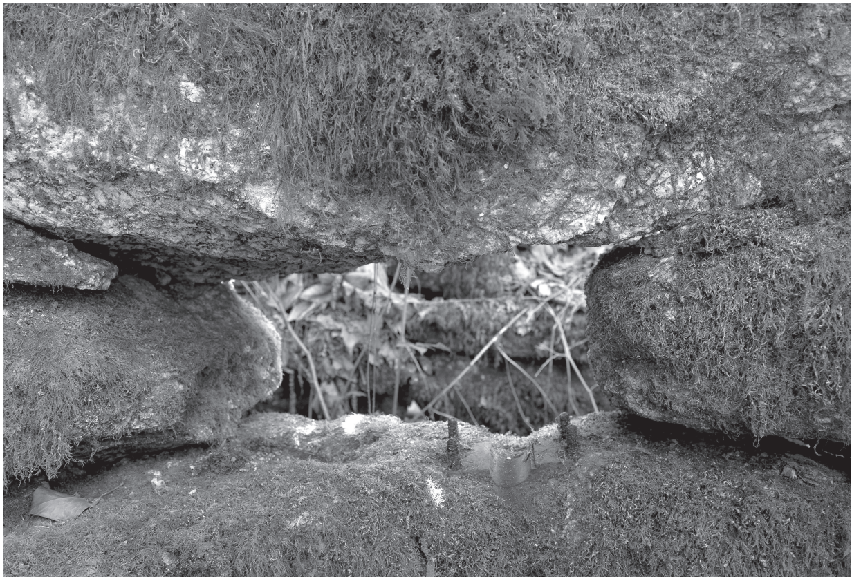
Fig. 7: Esquízo da planta do moinho e engenho de linho de Vale Covo (Alvite), e pormenor da chumaceira para o eixo que ligava a roda motriz vertical externa ao tambor do engenho de maçar
