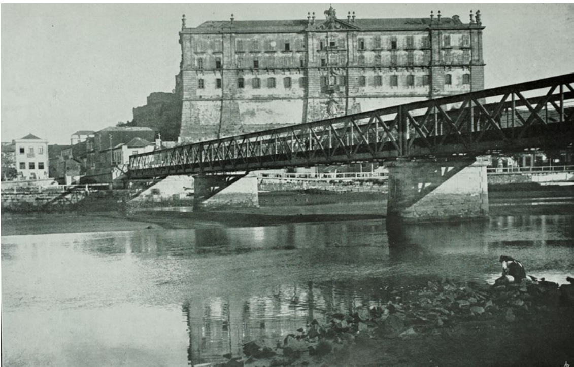
Fotografias 21 e 22— Vila do Conde e seu Alfoz. Fachada do “extinto” Mosteiro de Santa Clara sobre o Rio Ave (em cima); Ponte metálica sobre o rio Ave (em baixo).
