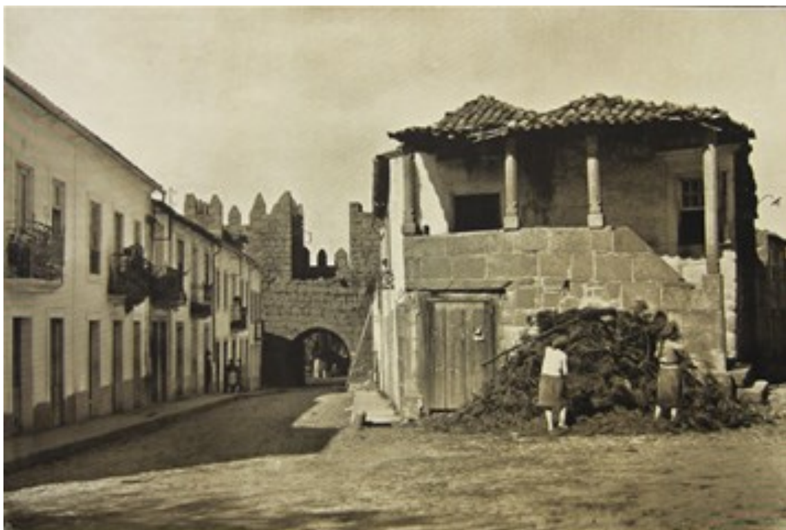
Fotografias 23 e 24— Isabel de Aragão, Rainha de Portugal . Trancoso—Porta del-rei D. Denis—Sul, face interior (em cima); Trancoso—Porta do Prado—Noroeste, face interior (em baixo).
