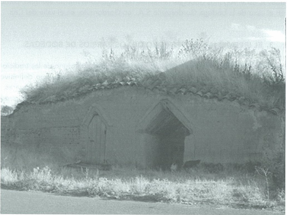
Figura 5 – Entrada a bodega en Valdevimbre (León). Foto J. Iglesia Berzosa
