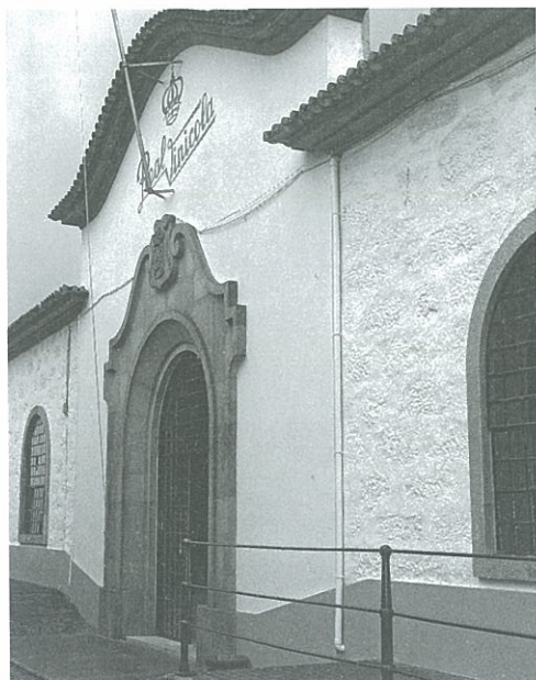
Fig. 2 | Instalações da RCUNP
