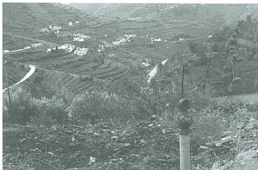
Fig. 5 | Espaço onde existia a casa destruída pelo fluxo de detritos de Alvações do Corgo
