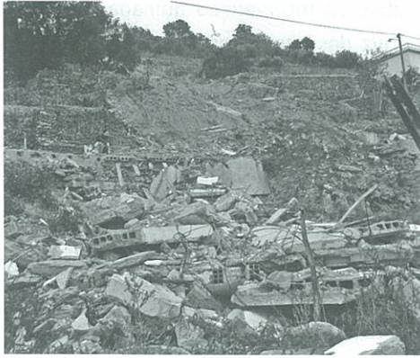
Fig. 10 | Vista de jusante da cicatriz do fluxo de Alvações do Corgo em 2001
