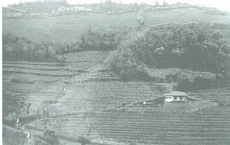
Foto 8 | Fluxo de detritos ocorrido em Cidadelhe (Janeiro, 2002)
