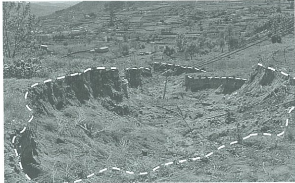
Fig. 7 | Cicatriz do Fluxo de Lama de Sta. Marinha do Zêzere de montante para jusante
