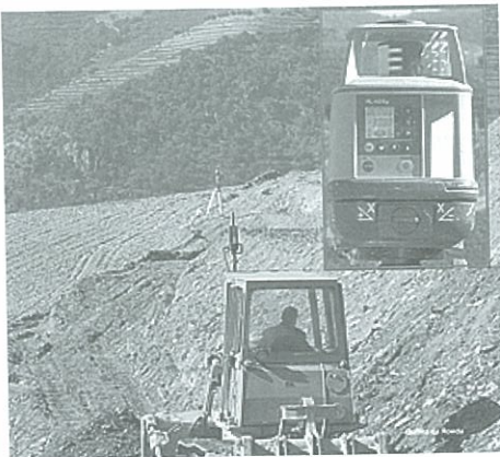
Fig. 33 | Implantação de patamares com tecnologia «laser»
