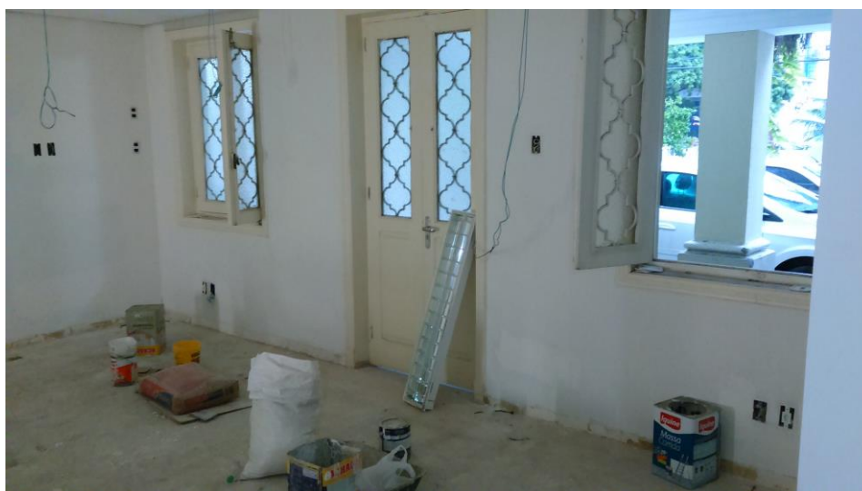
Imagem 2. Espaço em transformação: do administrativo ao museal. Pormenor das obras de adaptação da antiga Secção de Expedição do Tribunal Regional Eleitoral de Pernambuco
