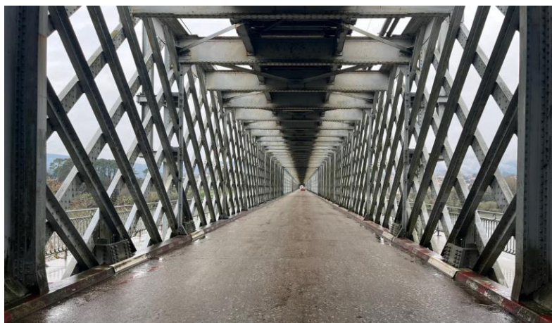
Figura 1: ponte internacional de Valença do Minho. Fonte: Acervo pessoal, 27/12/2024
