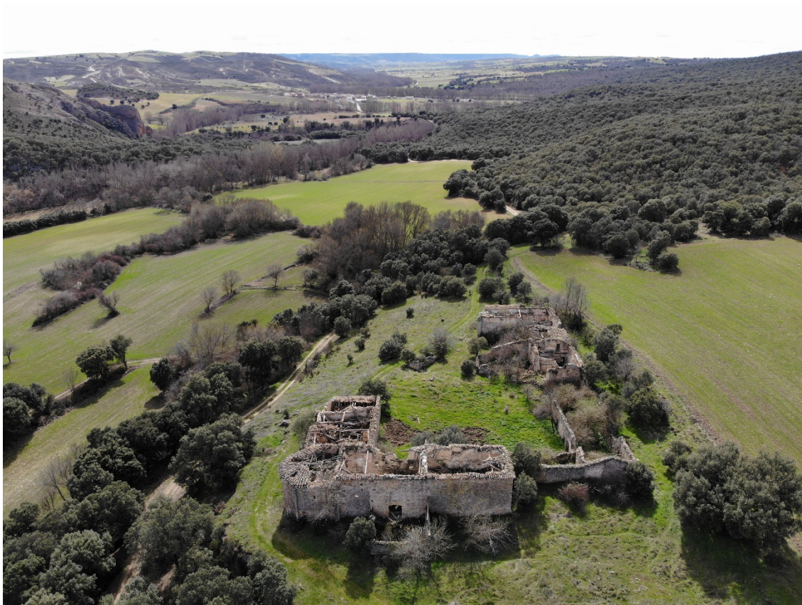
Fig. 1. Vista aérea de las ruinas del convento de San Salvador, con el río Cañamares a la izquierda y la localidad de Pinilla de Jadraque al fondo
