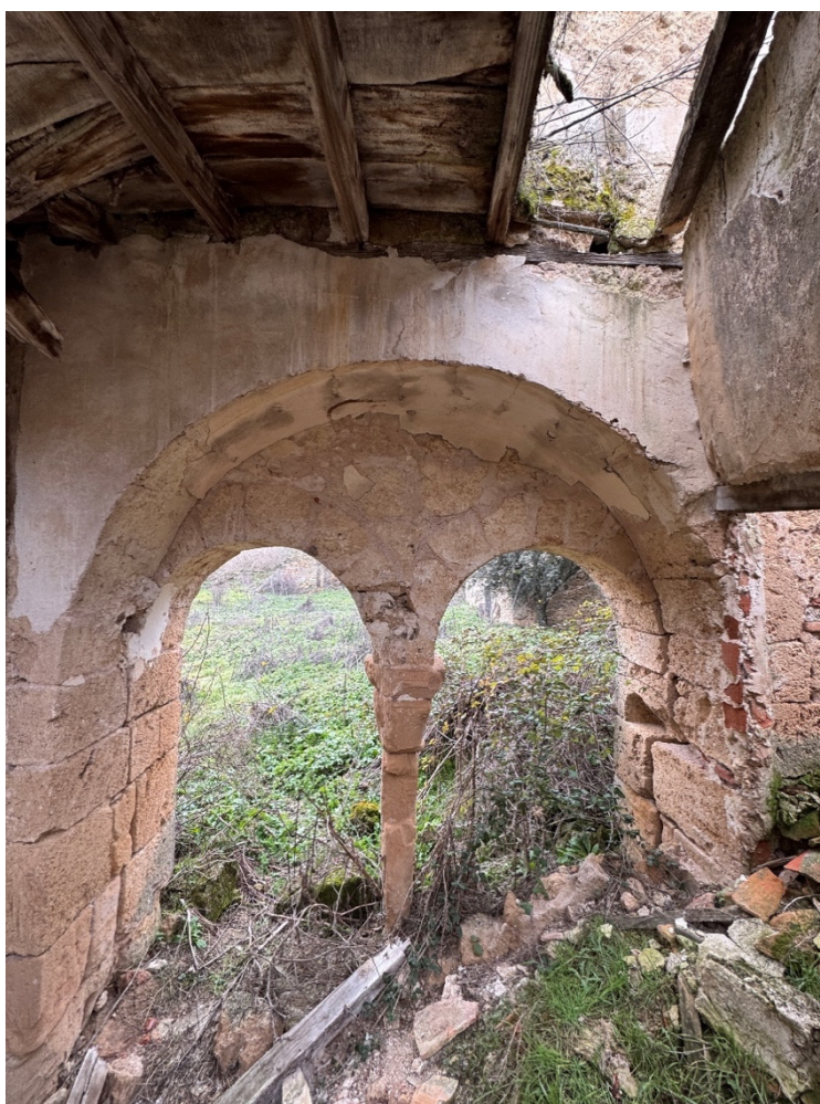
Fig. 13. Acceso a la sala capitular, visto desde su cara interna
