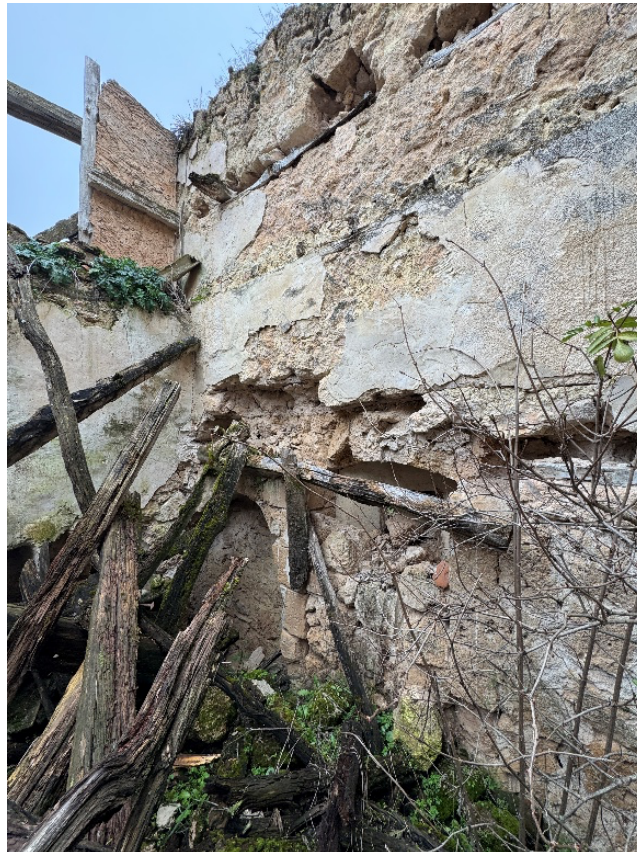
Fig. 11. Muro oeste de la sacristía
