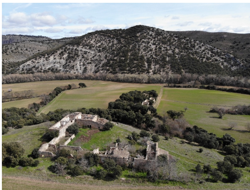
Fig. 17. Vista general desde el oeste, con el convento en primera instancia y la zona de huerta y dependencias auxiliares en el espacio abierto hacia el valle
