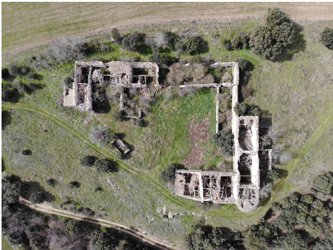
Fig. 3. Vista cenital del conjunto, con la iglesia en el extremo inferior derecho, la clausura en la parte central y la zona seglar en el extremo superior izquierdo
