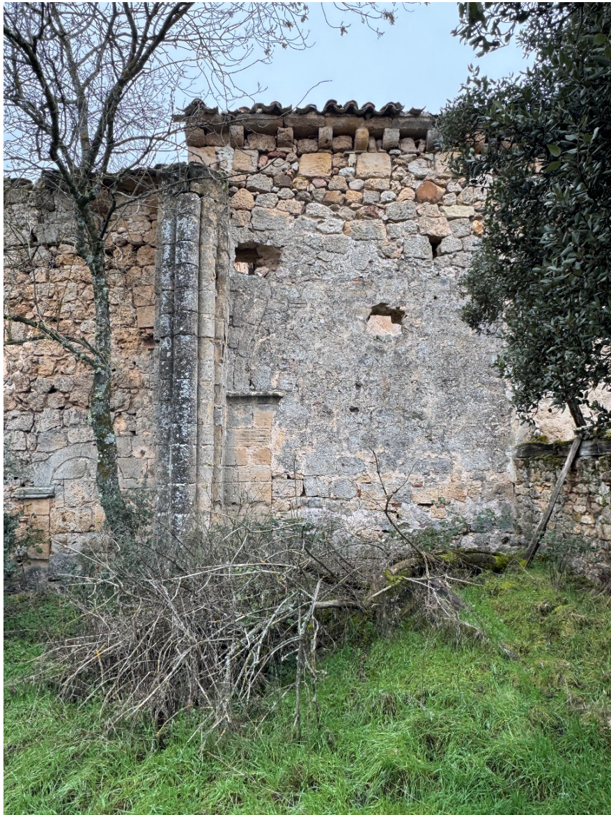
Fig. 6. Evidencias en el muro norte de una estructura inconclusa o desaparecida
