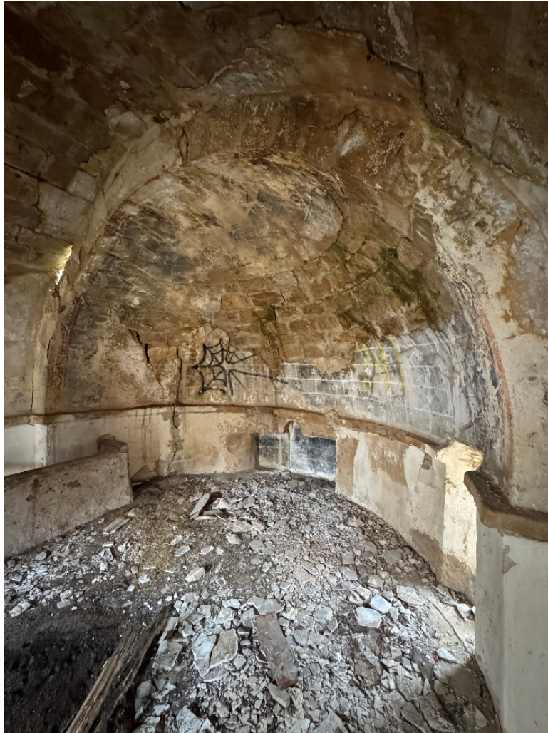
Fig. 7. Bóveda del ábside, con restos de policromía
