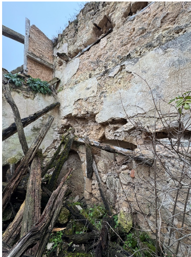
Fig. 11. Muro oeste de la sacristía
