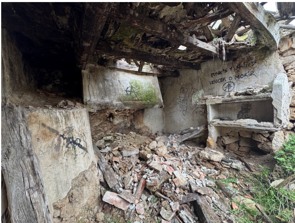
Fig. 14. Cocina situada en el sector oeste del convento
