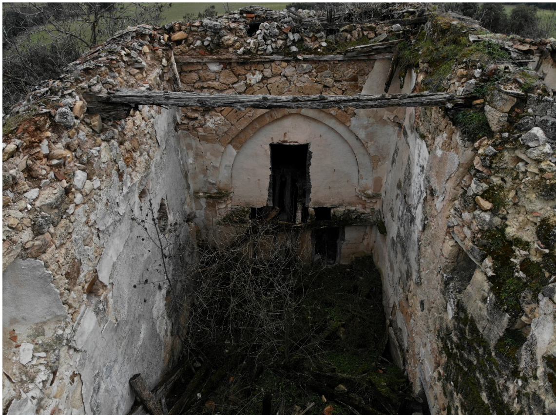
Fig. 9. Espacio interior de la nave y arco triunfal
