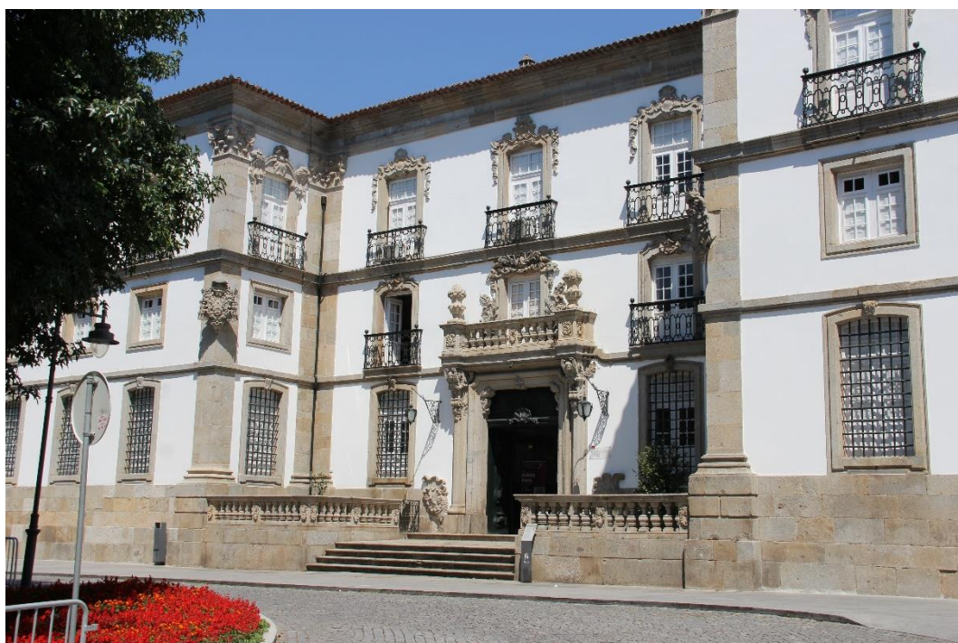
Biblioteca Pública de Braga, fachada
