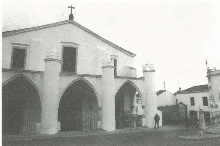
3 — Igreja de Santa Maria. Ao fundo, à direita, zona da escavação.
