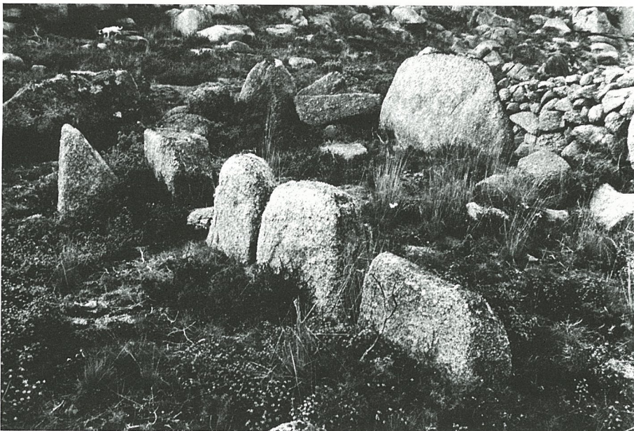
Fig. 2 — Povoado a sudeste do Castelo de Castro Laboreiro: pormenor de construção.
